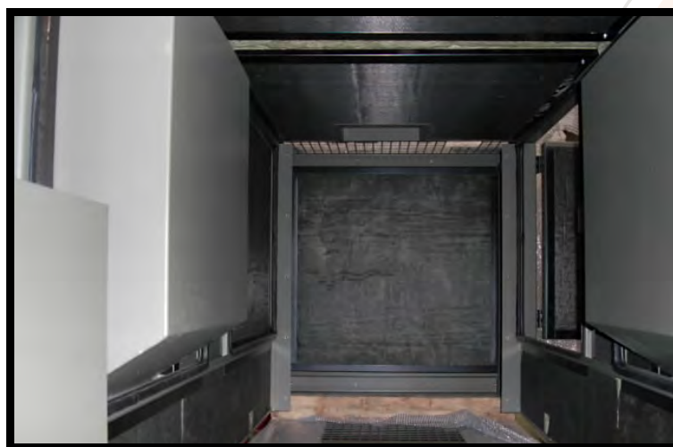
Imagen 3- Interior de un Grupo Electrónico insonorizado
